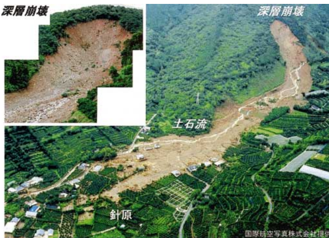
図3 針原川流域の深層崩壊と土石流
